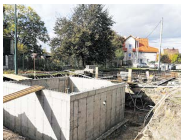
Modernizacja stacji uzdatniania wody w m. Smolec
