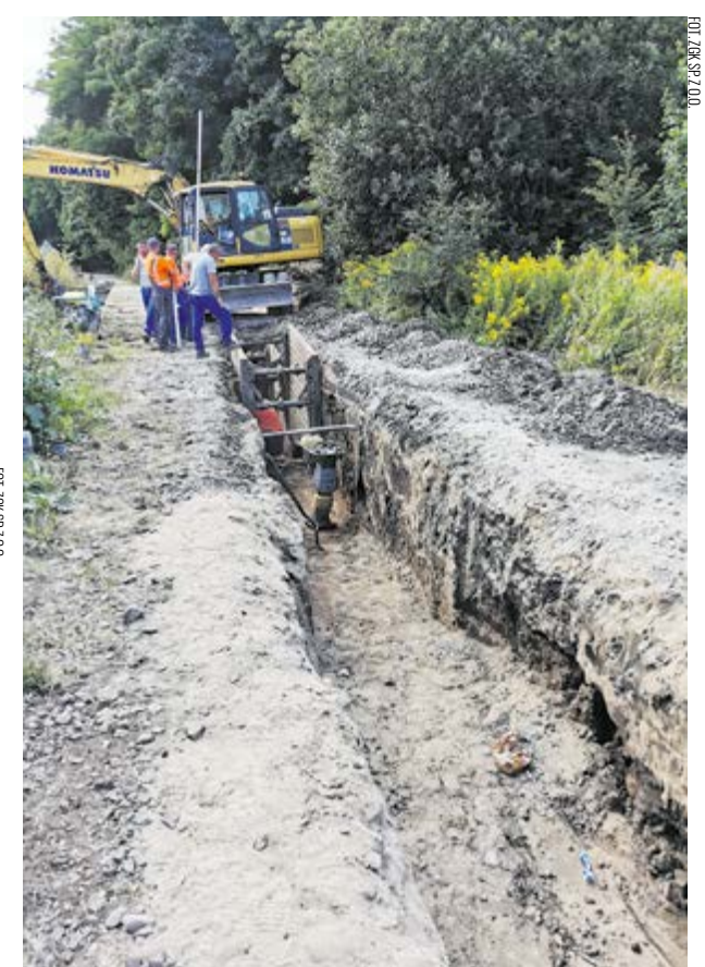
Budowa kanalizacji sanitarnej w ul. Parkowej, ul. Pogodnej ul. Rajskiej w m. Smolec
