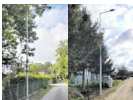
Nowe oświetlenie drogowe w Górzycach i Nowej Wsi Kąckiej
