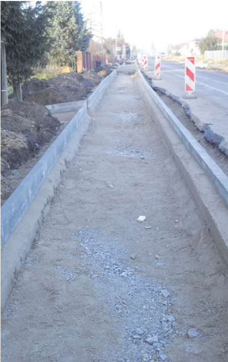
Budowa chodnika w Bogdaszowicach
