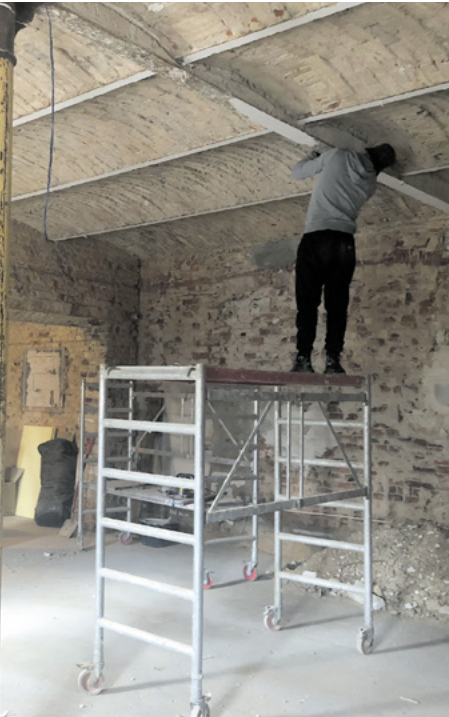
Remont świetlicy w Zabrodziu
