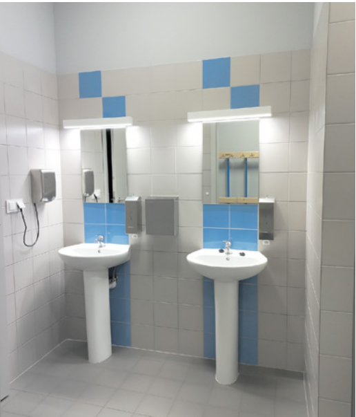
Sanitariaty przy szatni męskiej
