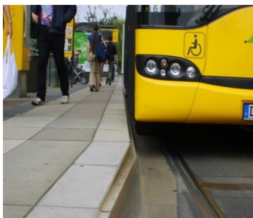
Rys. 7.1. Zalecane ukształtowanie krawędzi peronowej.
