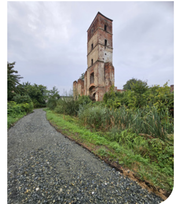
Nawierzchnie alejek parkowych
