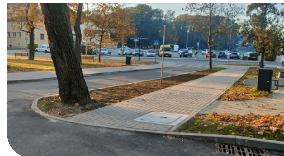
Ulica Parkowa przed i po remoncie
