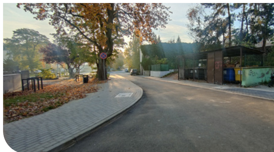
Ulica T. Kościuszki przed i po remoncie
