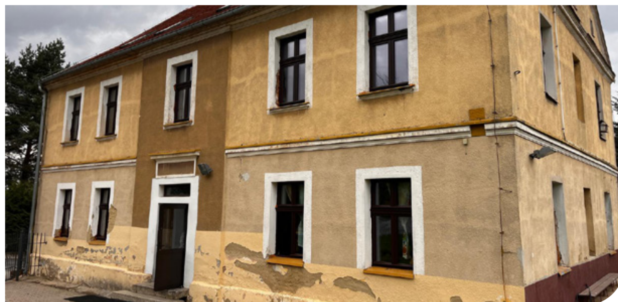
Niepubliczna Szkoła Podstawowa w Zachowicach po wymianie stolarki okiennej i drzwiowej
