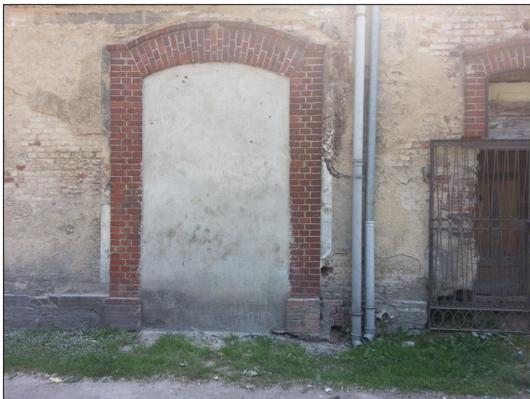
Fot. Budynek mieszkalno-gospodarczy – szczegół wykonania opaski drzwiowej
