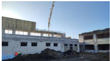
Fot. Widok na budynek A3 i A4
