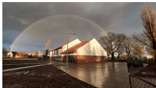
Fot. Sala gimnastyczna w Małkowicach
