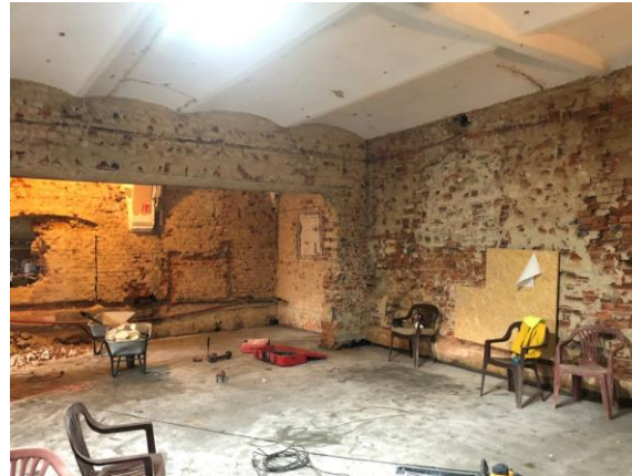
Fot. Remont świetlicy w Zabrodziu
