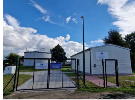
Fot. Stacja uzdatniania wody SUW Smolec
