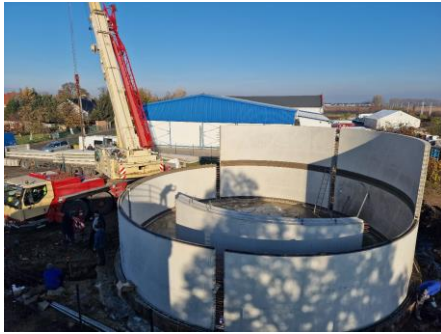
Rys. Budowa zbiornika wody czystej w miejscowości Smolec
