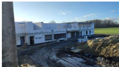
Fot. Widok na budynek A1
