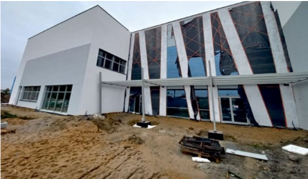
Trwa budowa nowej szkoły w Krzeptowie
