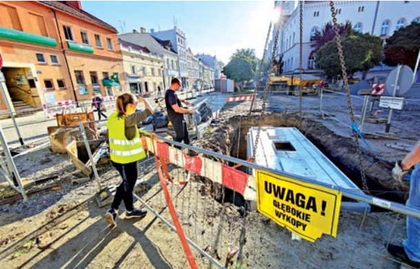
Montaż podziemnych pojemników na odpady
