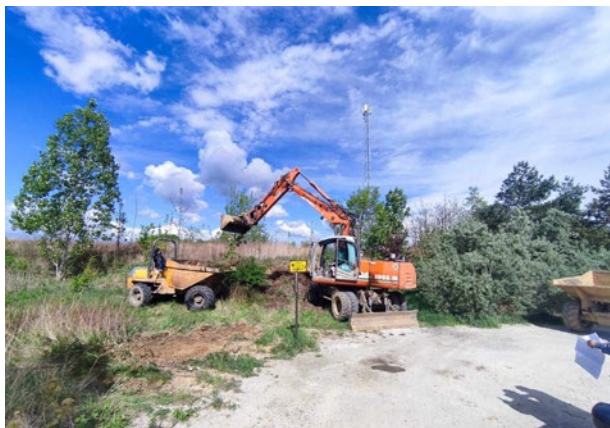
Prace nad pętlą autobusową w Bogdaszowicach
