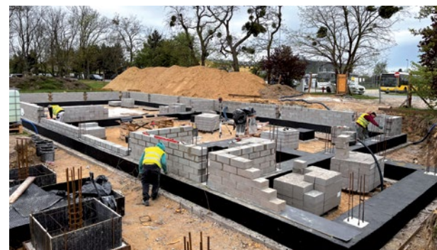
Trwa budowa świetlicy wiejskiej w Sadkowie
