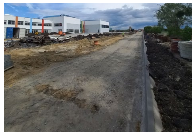
Budowa drogi wokół ZSP w Krzeptowie
