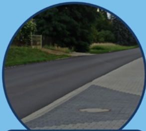
Budowę chodnika w Bogdaszowicach
