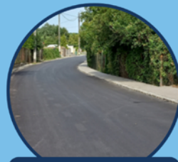
Budowę dróg np. Piwnej w Zachowicach
