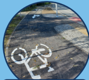
Budowę ścieżki rowerowej Mokronos Górny/Mokronos Dolny/Wrocław
