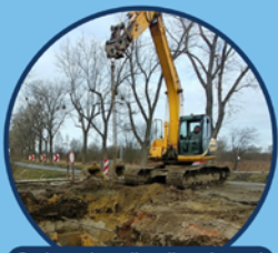
Budowę kanalizacji sanitarnej w Cesarzowicach, Mokronosie Górnym i Dolnym
