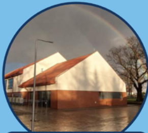
Budowę sali gimnastycznej w Małkowicach
