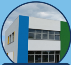
Budowę Zespołu-Szkolnego Przedszkolnego w Krzeptowie
