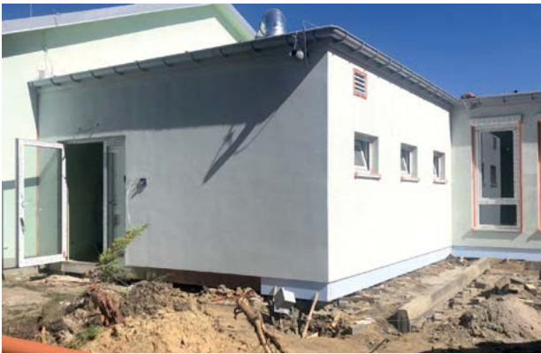
Widok na wejście do rozbudowywanej części przedszkola w Smolcu
