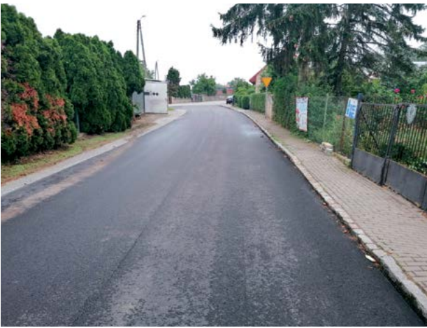
Remont drogi w Czerńczycach
