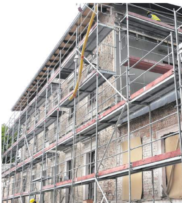
Budynek dworca PKP w Kątach Wrocławskich w trakcie remontu.
