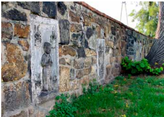
Zachowice - mur kościelny z płytami nagrobnymi
