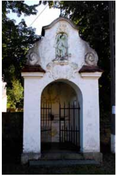
■ Bogdaszowice - kaplica w murze kościelnym
